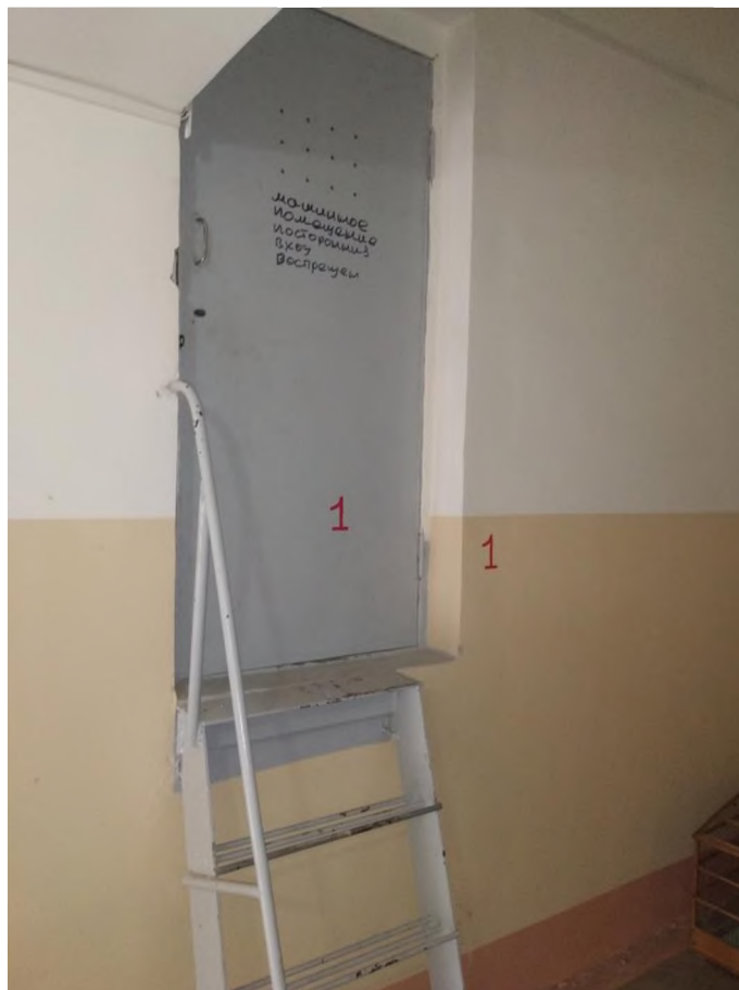
Рисунок 4 – Вход в машинное помещение
